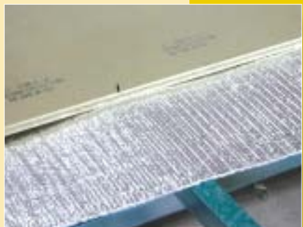
■ Isolation plancher Bulthermo, (R=2,6 m 2 KW) Classement au feu M1
