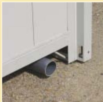
■ Raccordement sanitaire en pignon
